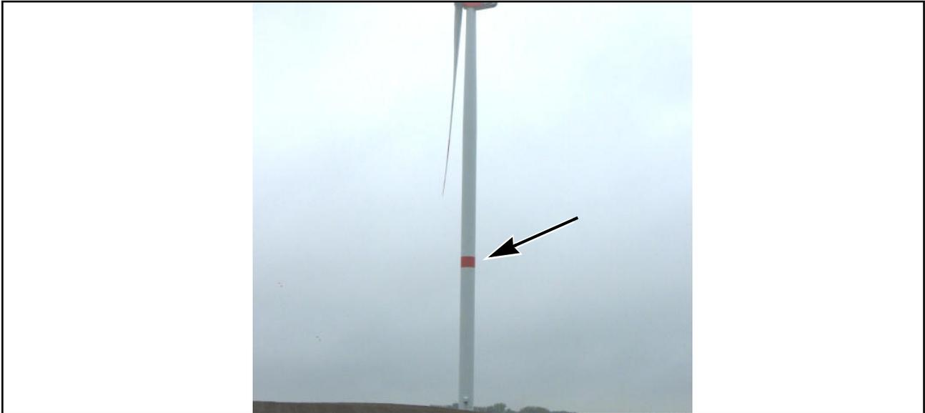
Abb. 4: Roter Farbring an Anlage mit Gesamthöhe >150 m
